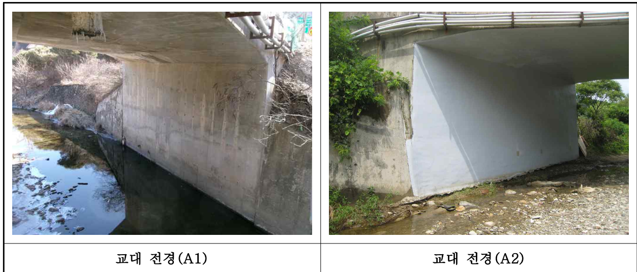
【사진 1.3.4】 교대 전경
