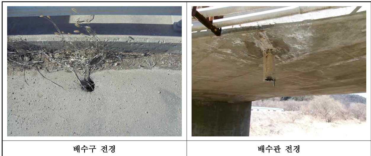
【사진 1.3.10】 배수시설 전경
