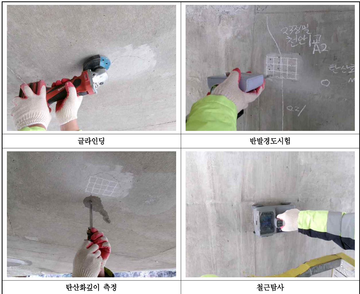
【사진 1.4.1】 콘크리트 내구성조사 현황
