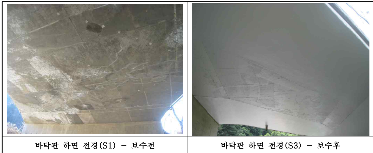
【사진 1.3.2】 바닥판하면 전경
