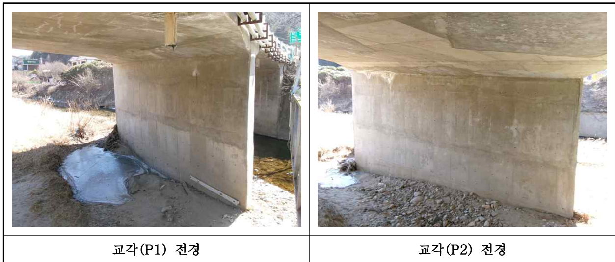
【사진 1.3.6】 교각 전경
